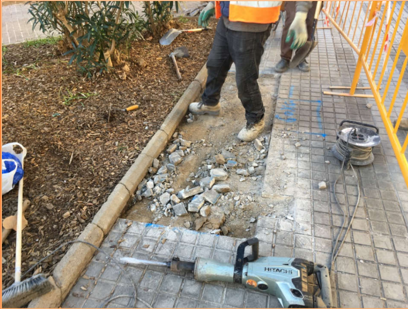
Foto 1. Inici dels treballs d'obertura de l'arqueta (UE 1).
