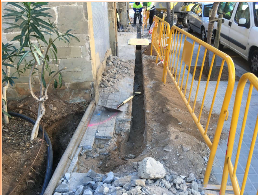
Foto 14. Treballs d'obertura de la rasa davant la façana de l'escola (UE 1 i UE 2).
