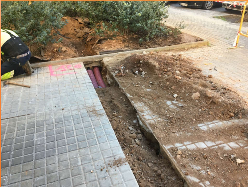
Foto 5. Treballs de cobriment de la rasa.
