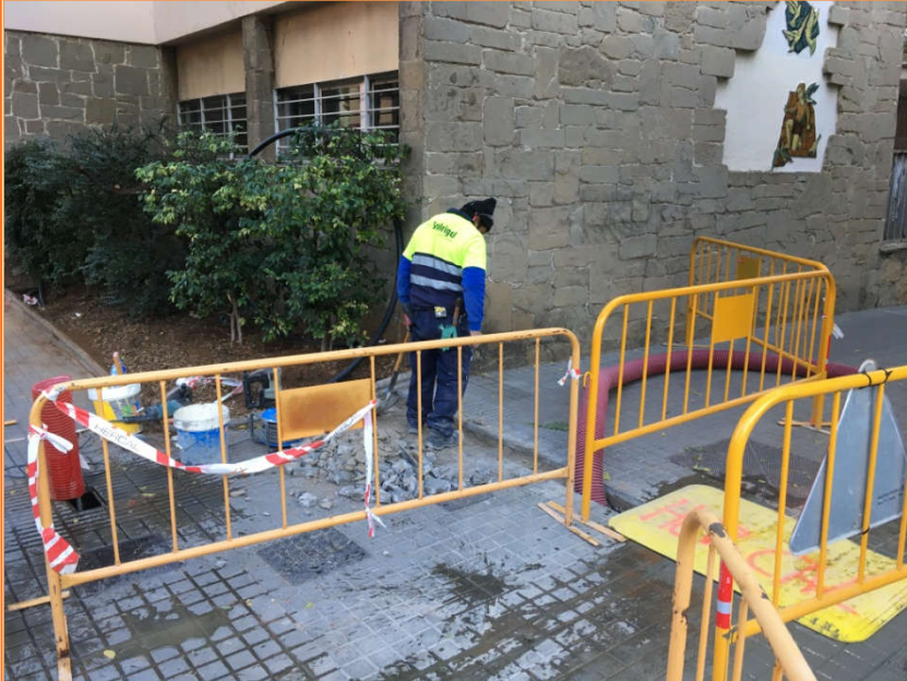
Foto 13. Treballs d'obertura de la rasa al carrer Felip II (UE 1).
