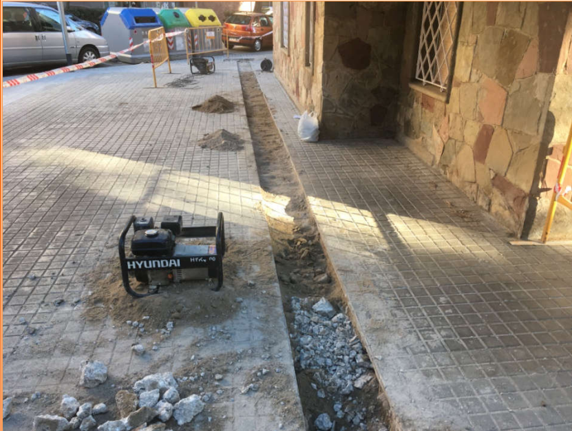
Foto 3. Treballs d'obertura de la rasa (UE 1).
