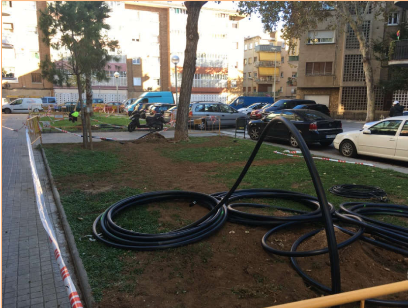
Foto 9. Treballs de cobriment de les rases als jardins.
