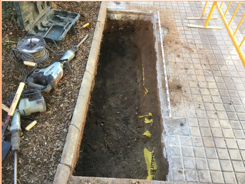
Foto 2. Estat final de l'arqueta
