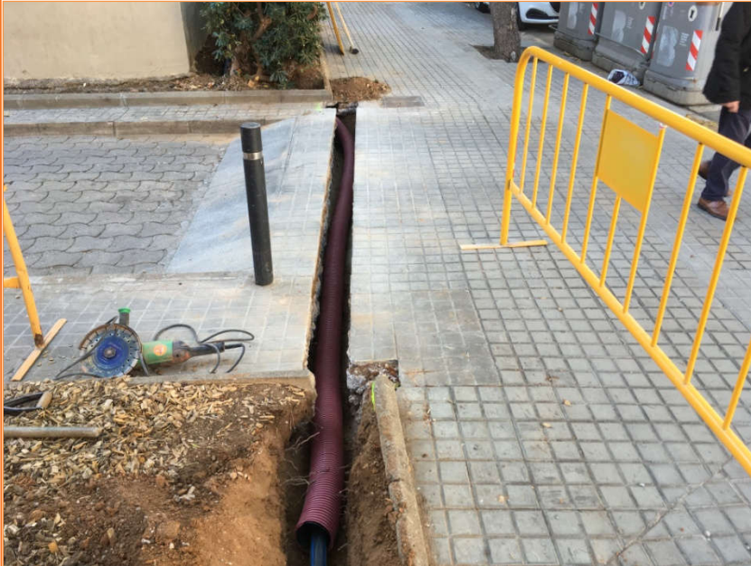
Foto 11. Treballs de cobriment de la rasa a la sortida del pàrquing.
