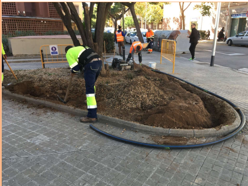
Foto 12. Treballs d'obertura de la rasa al jardí nord (UE 3).
