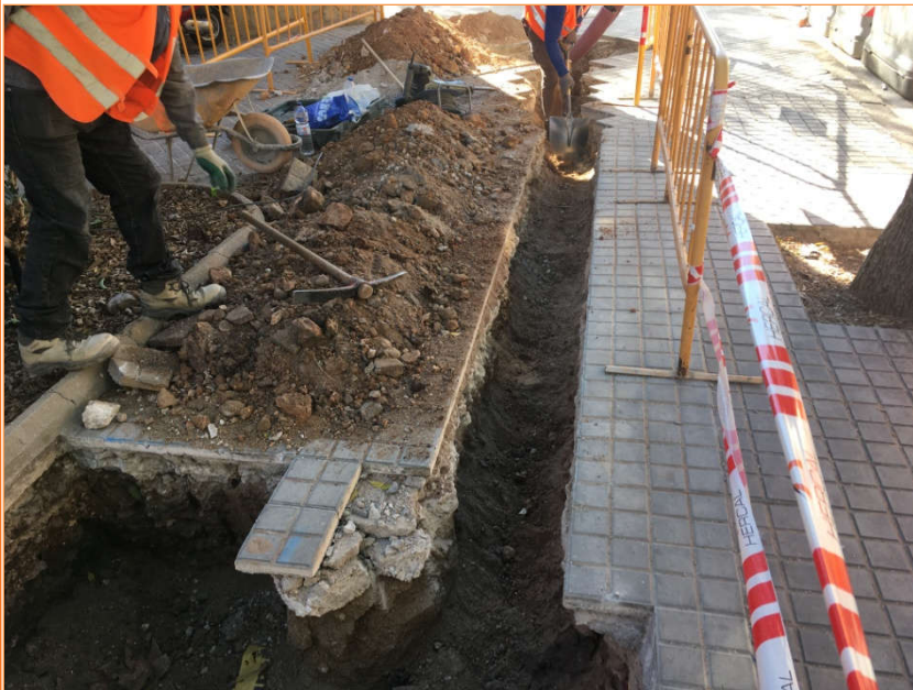
Foto 10. Treballs d'obertura de la rasa entre l'arquetes (UE 2).
